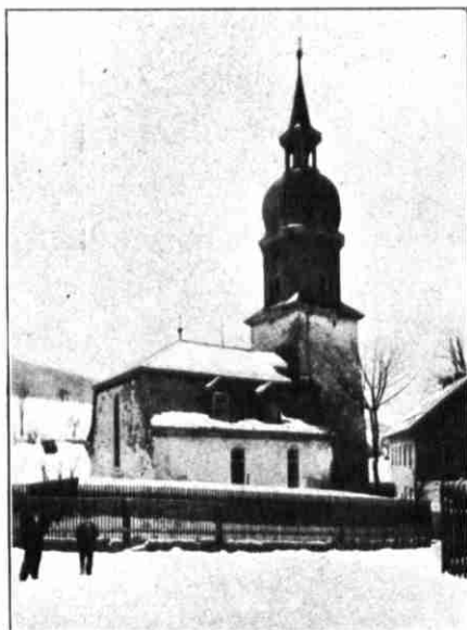
Abb. 1. Kirche in Ebersdorf in Oberfranken.
