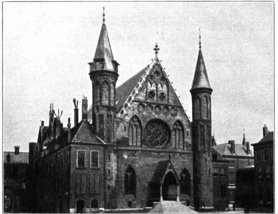
Abb. 3. Der Rittersaal vor der Wiederherstellung (1896).
