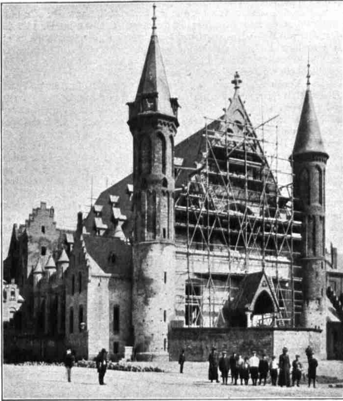
Abb. 7. Der Rittersaal während der Wiederherstellung 1903.
