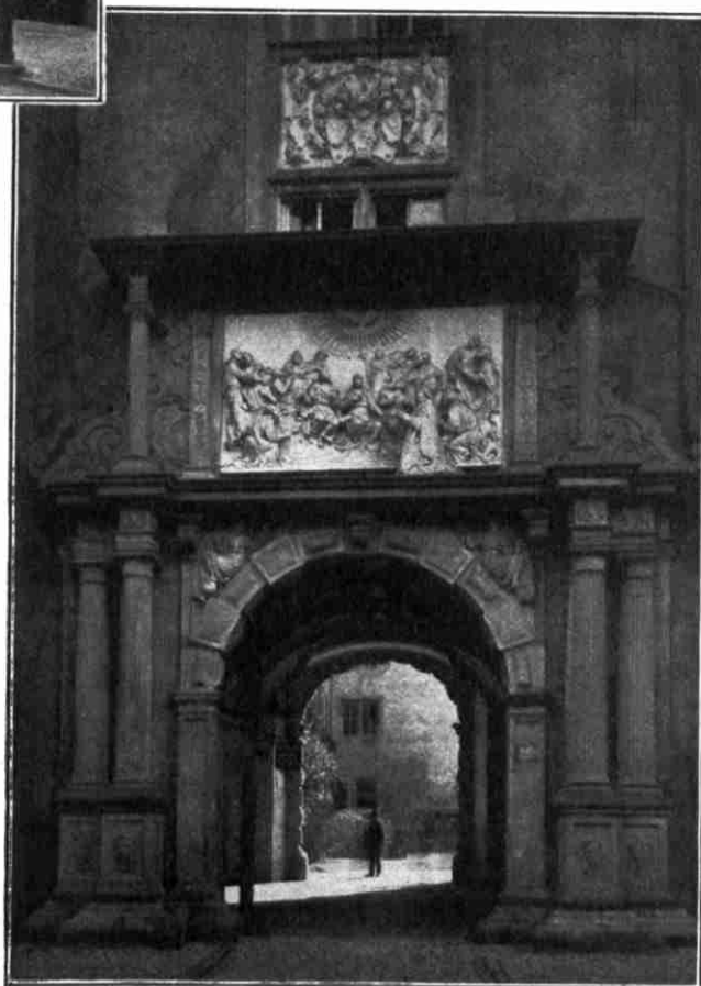
Abb. 6. Hauptportal der Universität in Würzburg.
