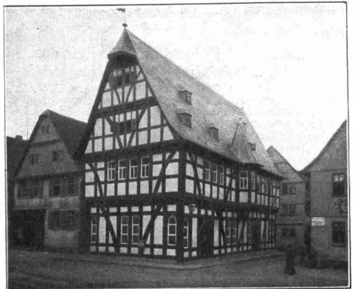
Abb. 4. Nach der Wiederherstellung und Erweiterung.
