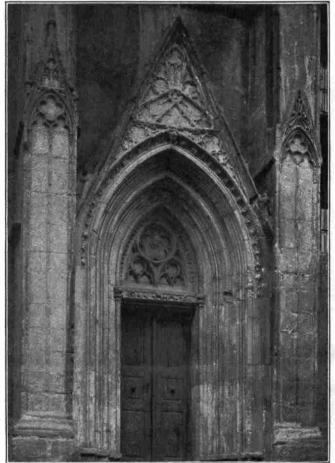
Abb. 8. Südportal der Deutschhaus-Kirche in Würzburg.
