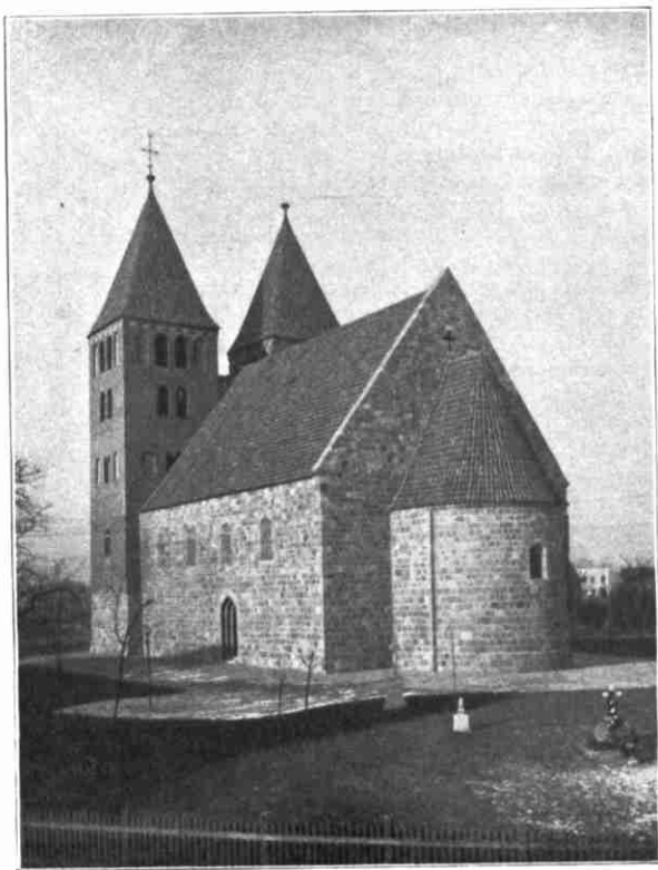
Abb. 1. Ansicht von Südosten.
