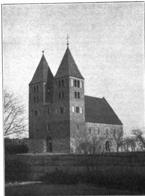
Abb. 2. Ansicht von Südwesten.
