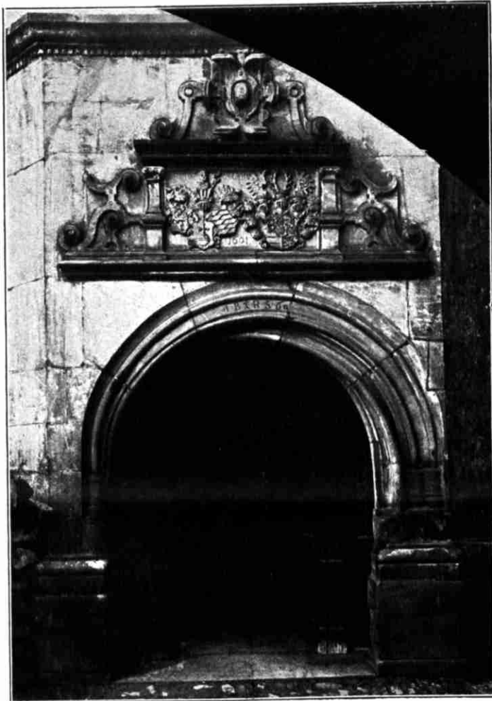
Abb. 1. Amberg. Portal im Hof des Landgerichtsgebäudes.
