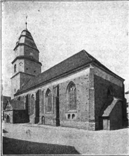
Abb. 4. Südost-Ansicht. Vor dem Bau.
