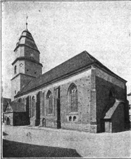
Abb. 4. Südost-Ansicht. Vor dem Bau.
