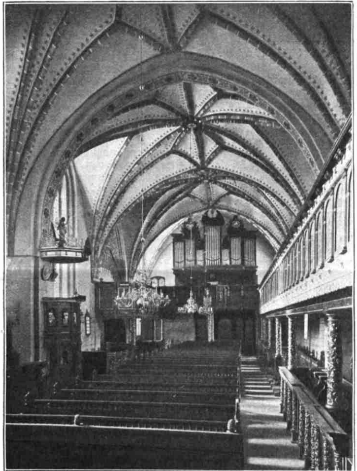
Abb. 2. Blick vom Altar in das Schiff. Nach dem Bau.
