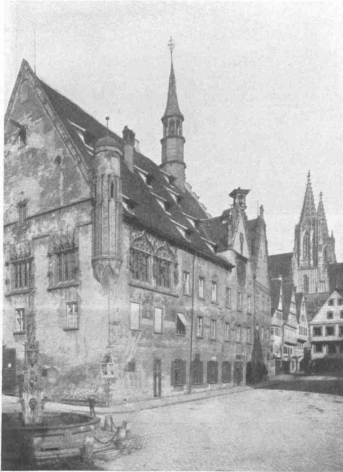
Abb. 1. Rathhaus in Ulm vor dem Umbau.
