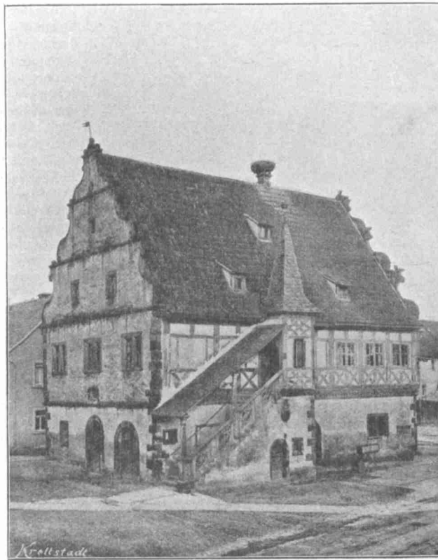
Abb. 4. Rathhaus in Krettsstadt bei Schweinfurt (Arch. Julius Echter 1590).
