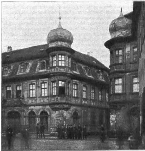
Abb. 3. Marktbreit. Eckhäuser in der Hauptstraße.
