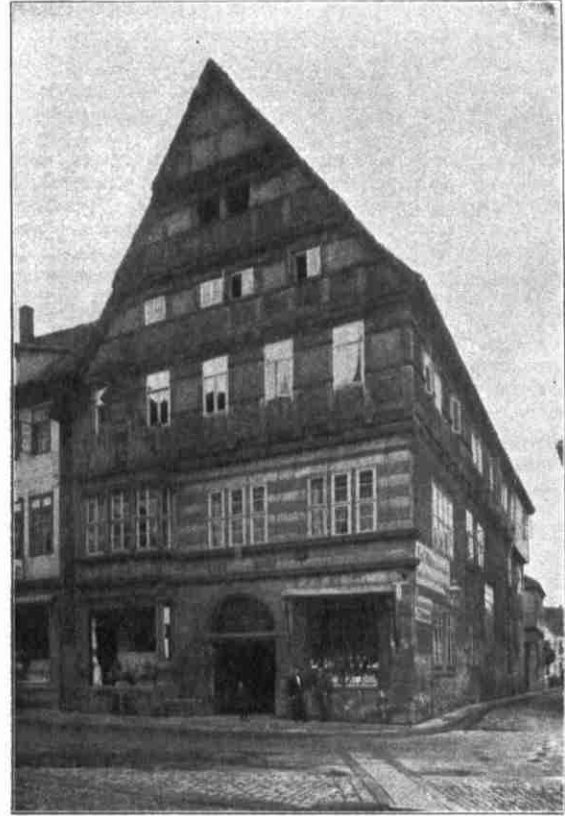
Abb. 6. Das Demptersche Haus in Hameln mit hineingebrochenen Laden-Schaufenstern.
