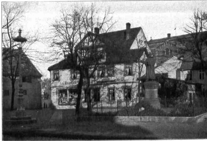
Abb. 4. Gothisches Haus am Münsterplatz nach dem Umbau.
