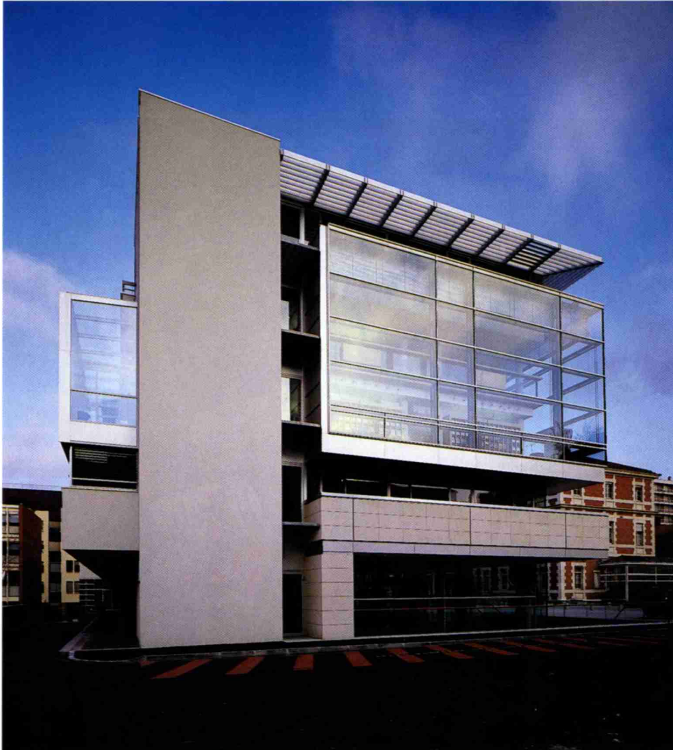
52 Bibliothèque de l'Institut Pasteur, Paris, façade ouest
