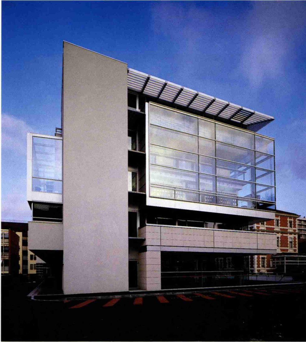
52 Bibliothèque de l'Institut Pasteur, Paris, façade ouest
