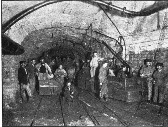
Fig. 10. Hauptförderstrecke in der Grube Joudreville.
