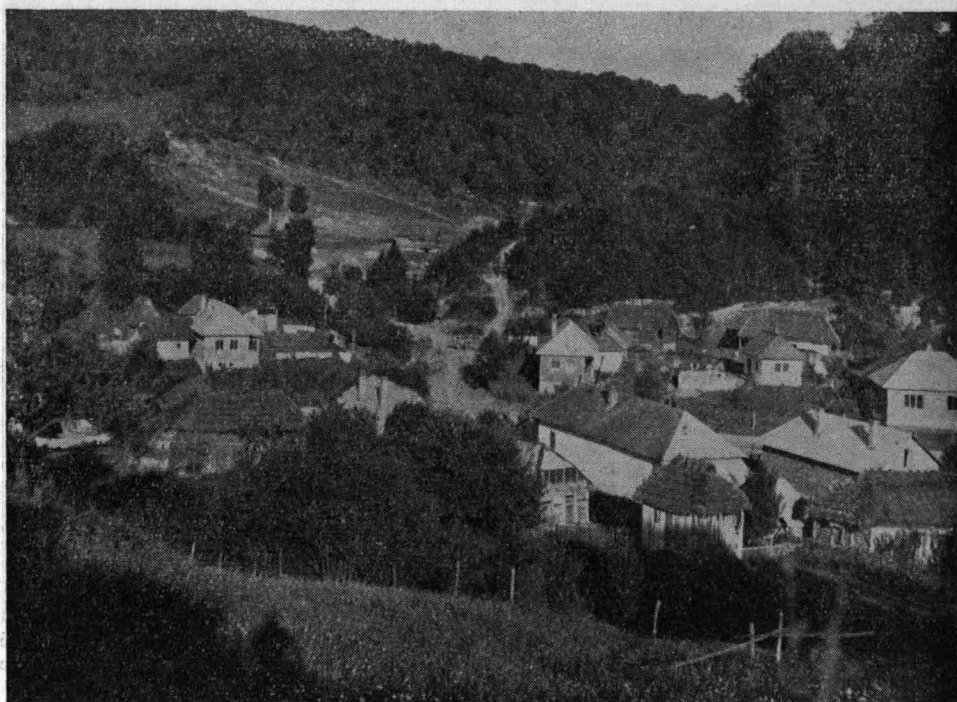
Obr. 2. Pohľad na dolnú časť obce Ruská Poruba so starými a novými hospodárskymi objektami. Za obcou západné svahy návršia Hôrky s devastovaným lesom a vrchu Skaljane (úplne vzadu), ktorými prebiehala trasa II.
