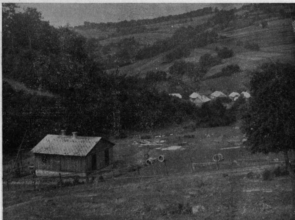
Obr. 3. Pohľad na východný svah vrchu Kopanice, kadiaľ prebiehala trasa I. Na svahu sú viditeľné strže medzi poľami, krovinaté medze a na vrchole kopca časť starého bukového lesa. Vpredu je budova stacionáru ohraničená okopmi.
