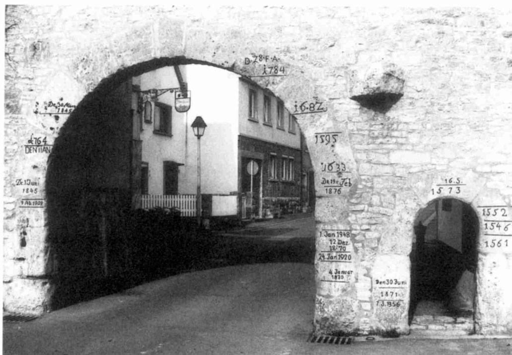
Bild 1. Hochwassermarken am Maintor in Eibelstadt High-water marks at the Maingate in Eibelstadt
