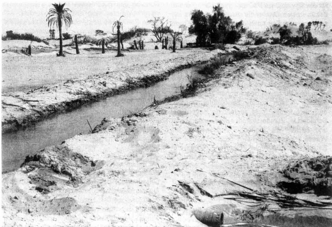
Bild 2. Unbefestigter Hauptkanal mit Wasserverlusten von bis zu 85 % auf 1,2 km Länge (Kharga: Shirka) Non-cemented main canal with a water loss of up to 85 % on a length of 1.2 km
