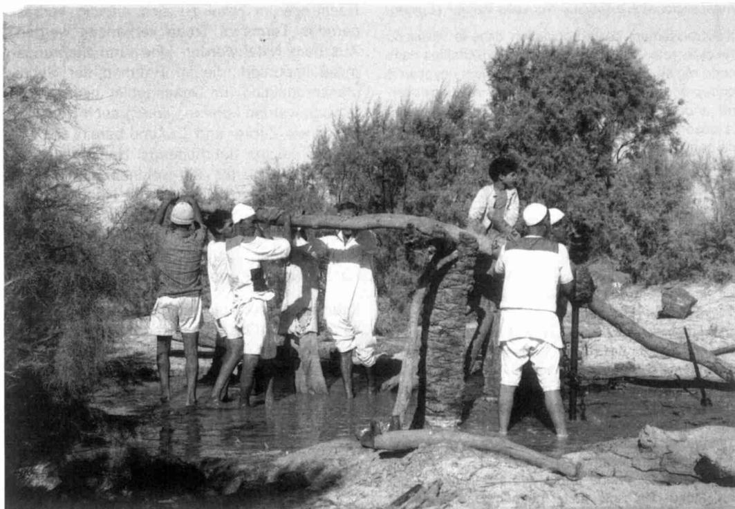
Bild 1. Bohreinrichtung für Flachbrunnen bis zu 110 m: Bohrteam unter der Anleitung eines Bohrmeisters (arab.: usta) Drilling-machine for shallow wells up to 110 m: the drilling-team is working under the supervision of the »usta« (foreman)
